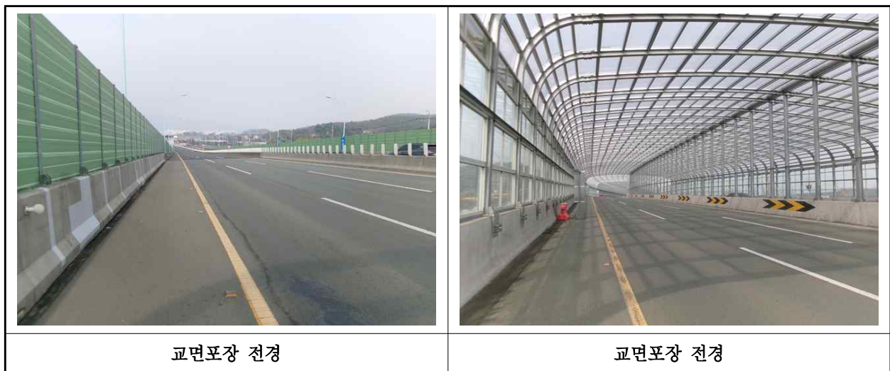
【사진 3.3.20】 교면포장 전경
