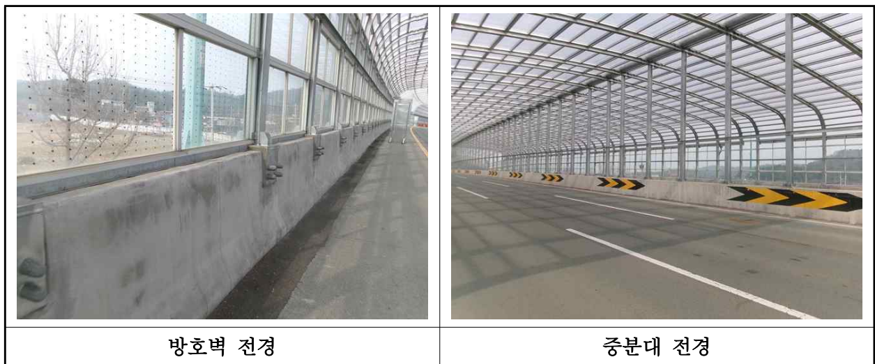
【사진 3.3.24】 방호벽 및 중분대 전경
