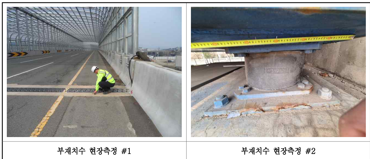
【사진 3.2.1】 부재 현장측정 전경
