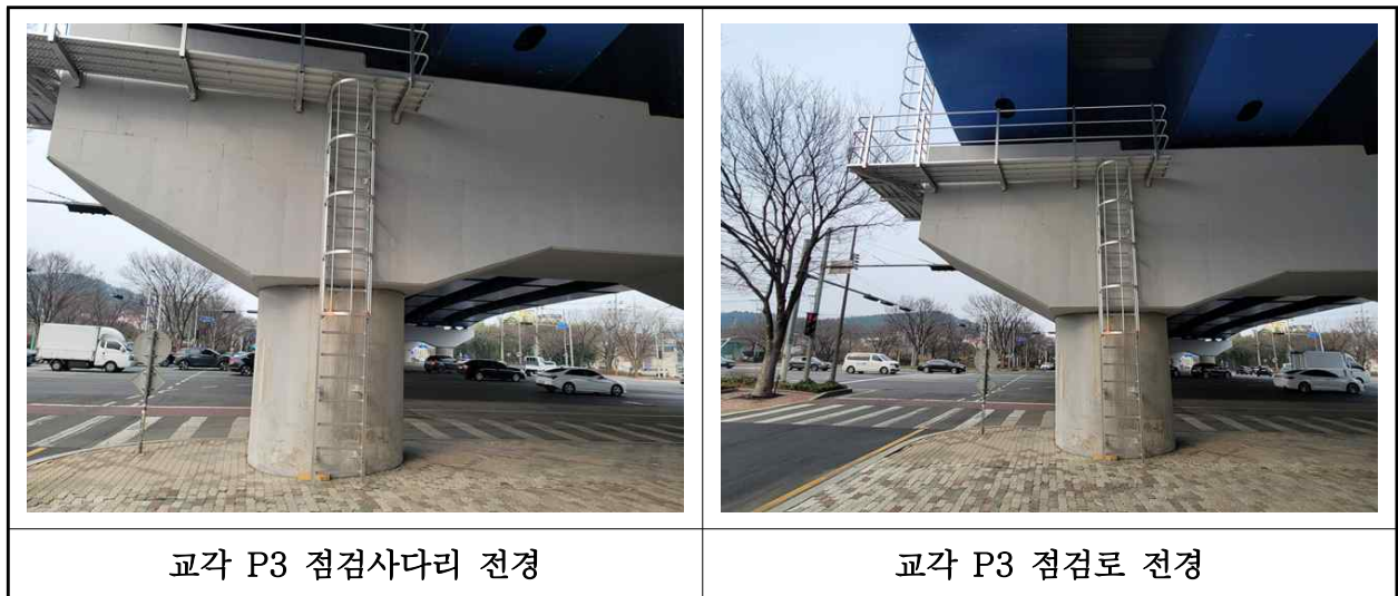
【사진 3.3.26】 교량 점검시설 전경
