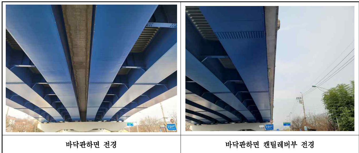
【사진 3.3.2】 바닥판하면 전경
