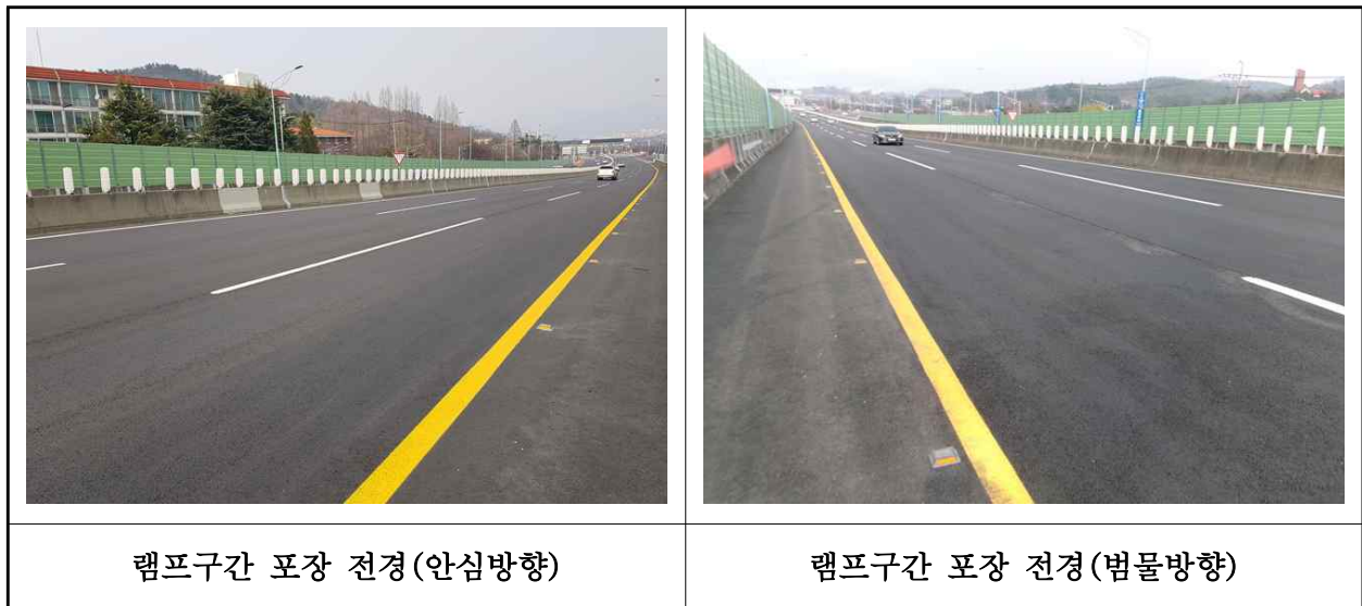
【사진 3.3.28】 램프구간 포장 전경
