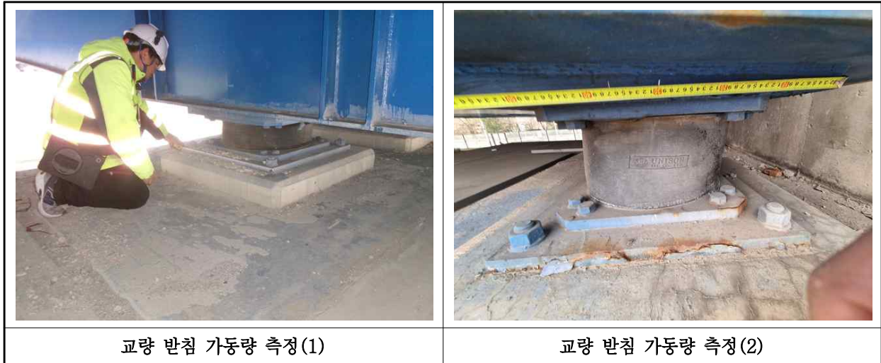
【사진 3.3.16】 교량받침 이동량 측정
