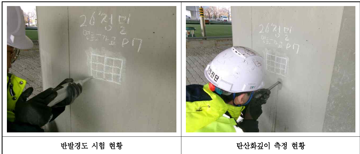
【사진 3.4.1】 콘크리트 내구성조사 현황
