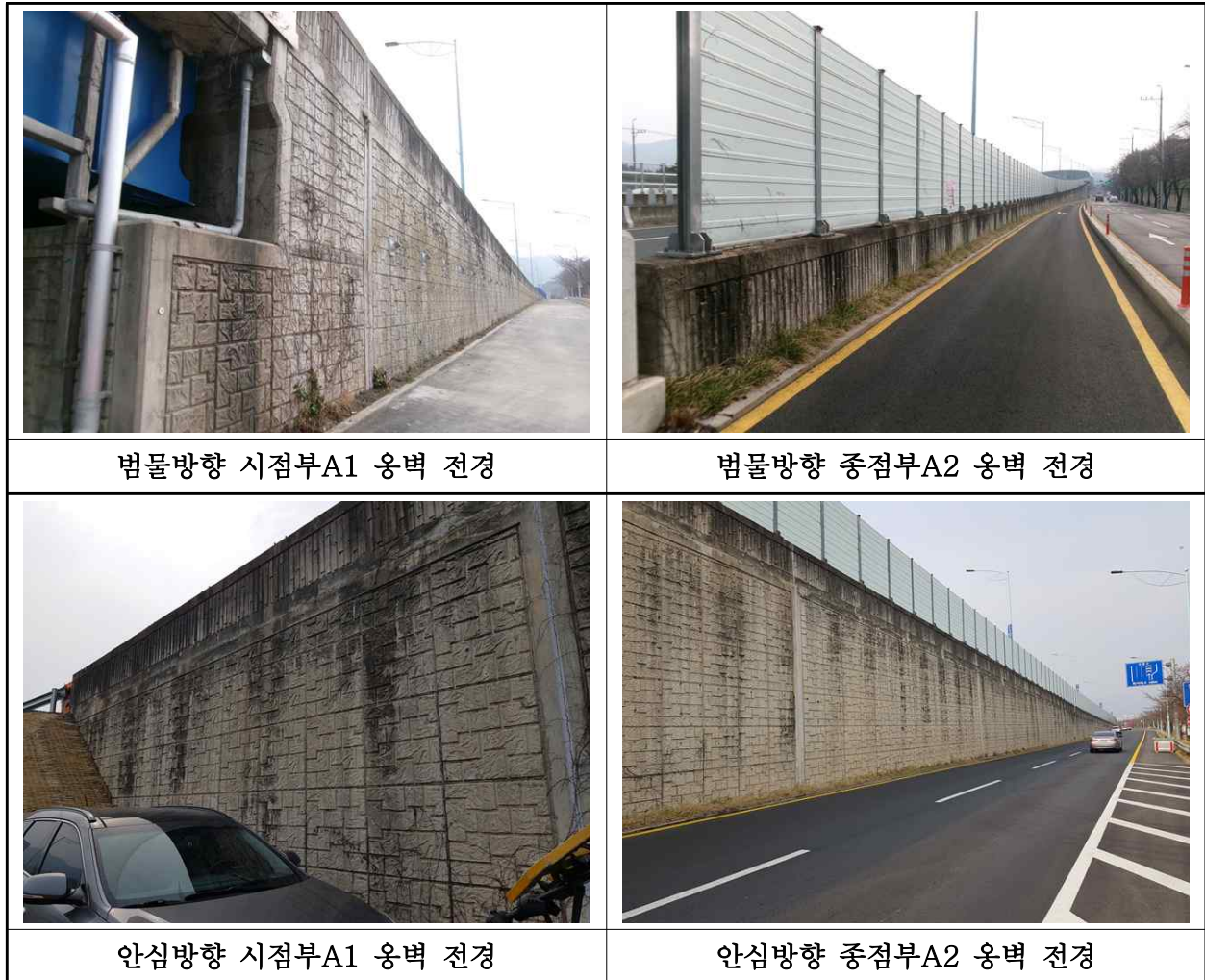
【사진 3.3.30】 램프구간 하부 옹벽 전경
