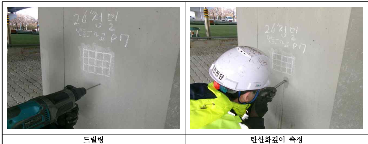
【사진 3.4.3】 탄산화 깊이 측정 현장사진
