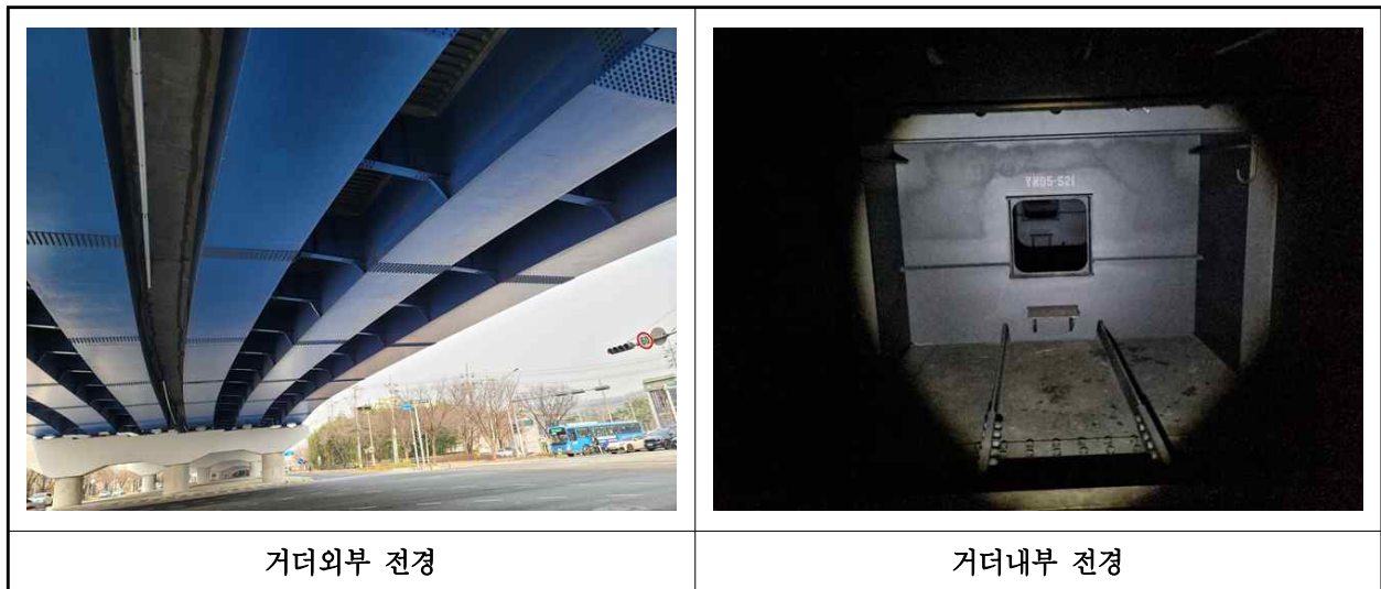
【사진 3.3.4】 거더 전경
