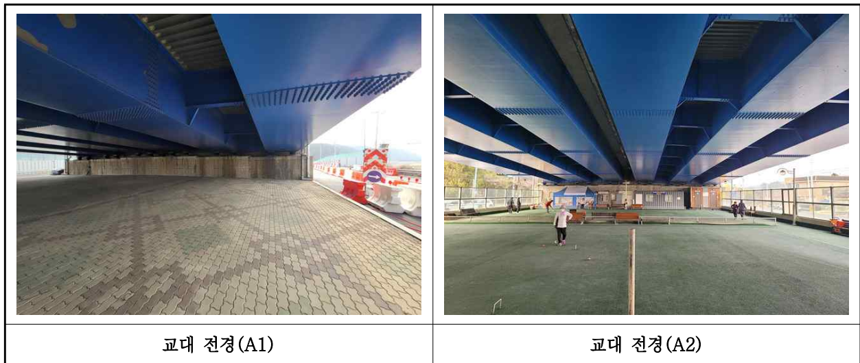
【사진 3.3.8】 교대 전경
