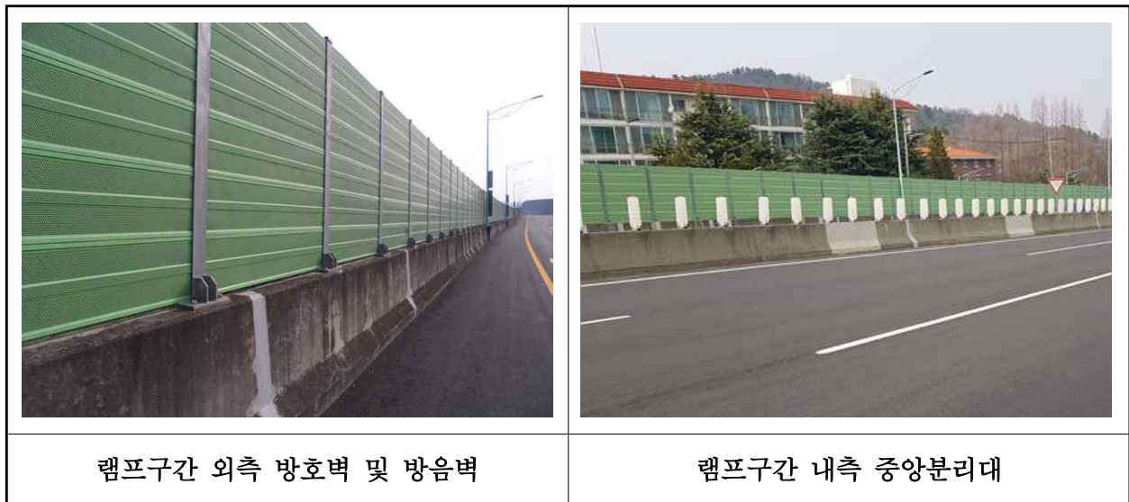
【사진 3.3.30】 램프구간 난간 및 연석 전경
