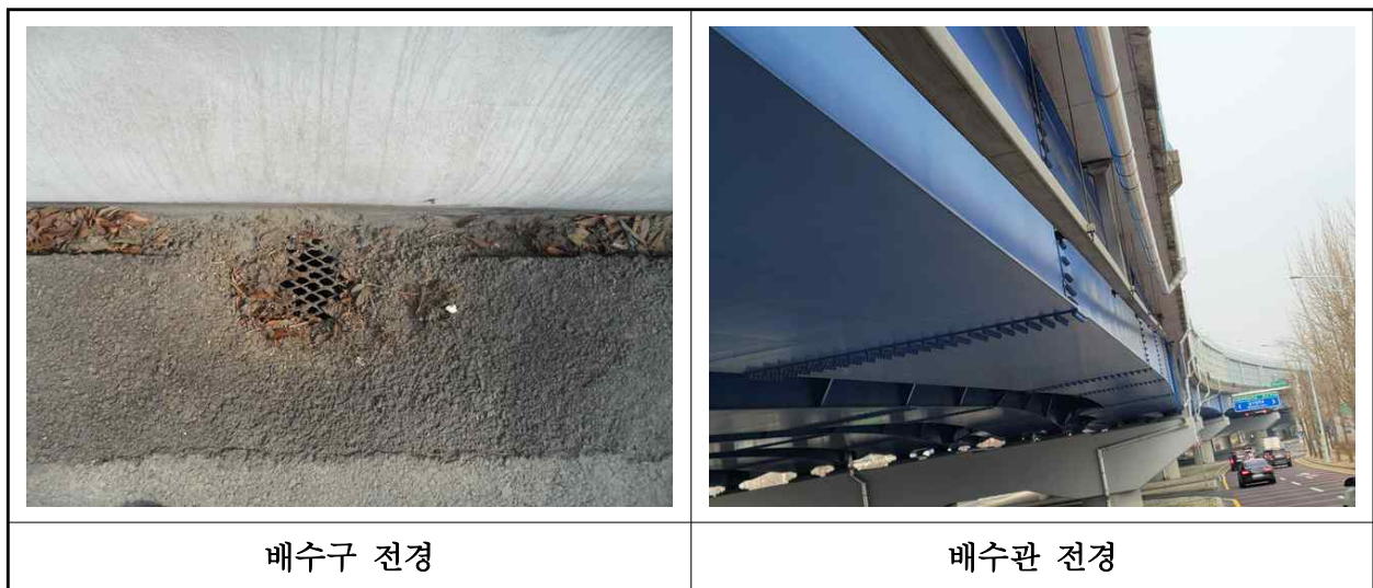
【사진 3.3.22】 배수시설 전경
