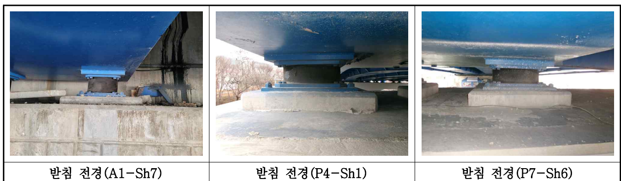
【사진 3.3.13】 교량받침 전경
