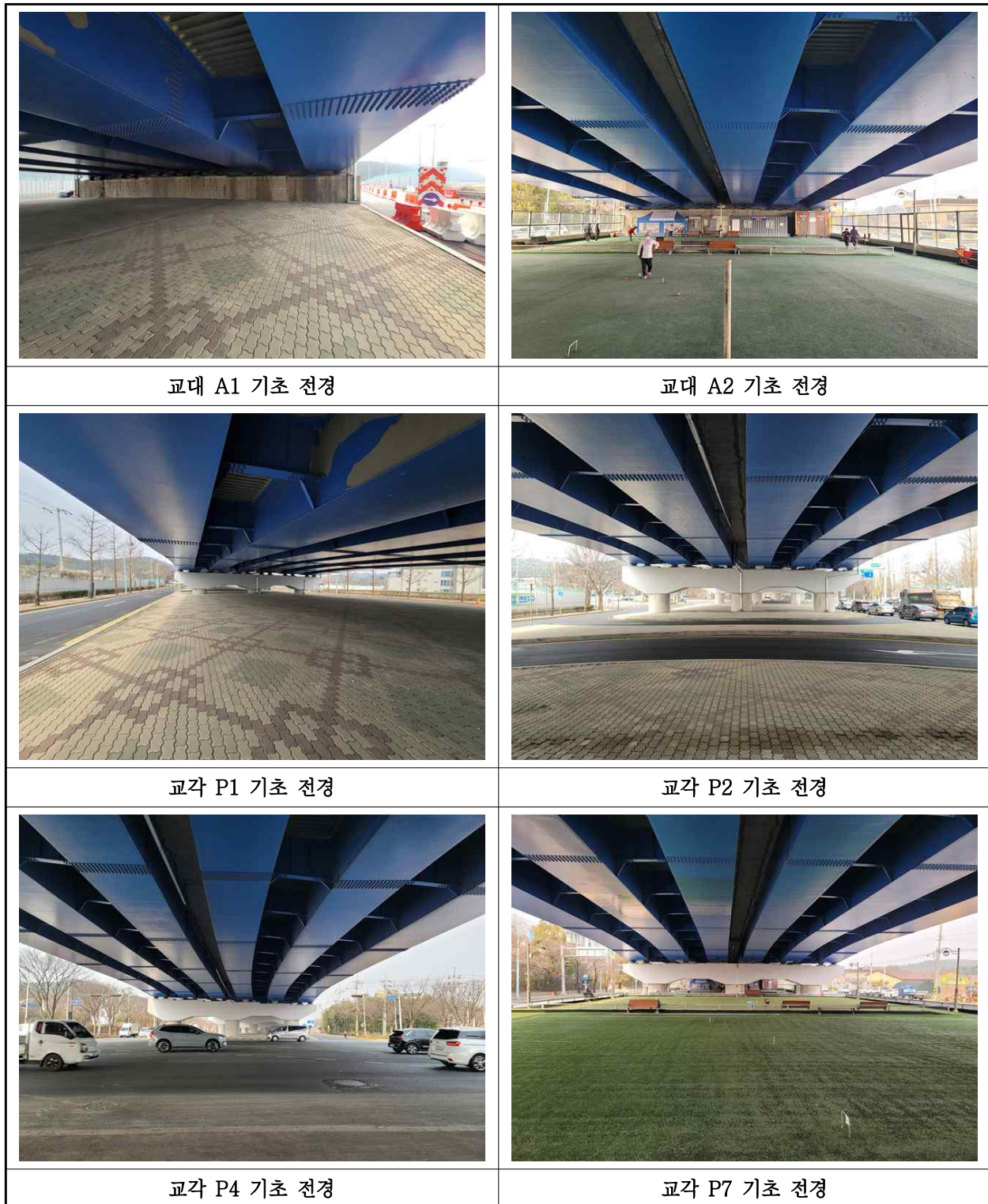
【사진 3.3.12】 기초 전경
